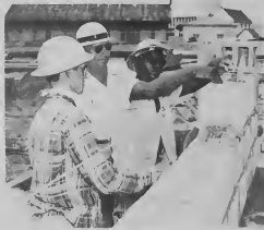
TRADESMAN Tramee Pedro Arends and Tradesman B Fernando Leerdran build a concrete block wall as Trainer H. A. Mathiasen watches. TRADESMAN Pedro Arends and Tradesman B. Fernando Leerdran ta traha un muraya di blokki concreto mientras Trainer H. A. Mathiasen ta waak.
